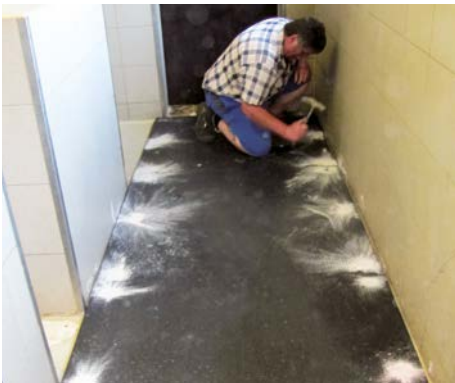
dann werden die Matten mit Nageldübeln befestigt
